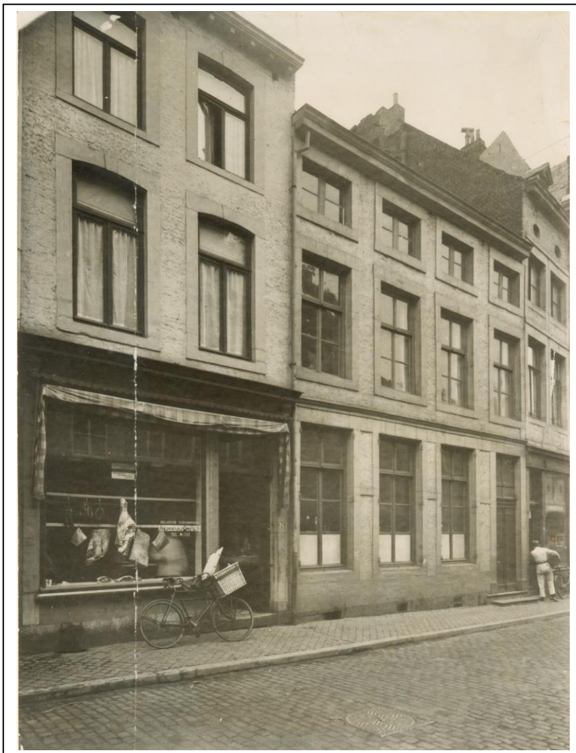
Dit was de slagerij van Abraham Vredenburg aan de Brusselsestraat 24. Achter het raam is het silhouet van Abraham zichtbaar bij de voordeur. Bron: HCL beeldbank nr. 11903
